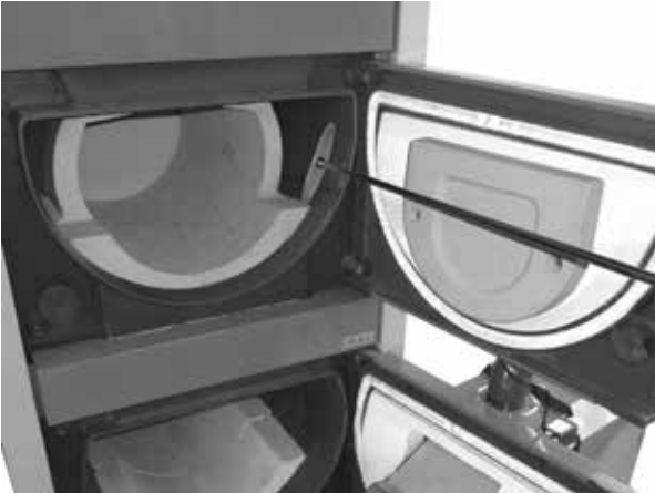
Otevřená prostřední dvířka kotle s ukázkou vyhrabování popela pomocí pohrabáče
