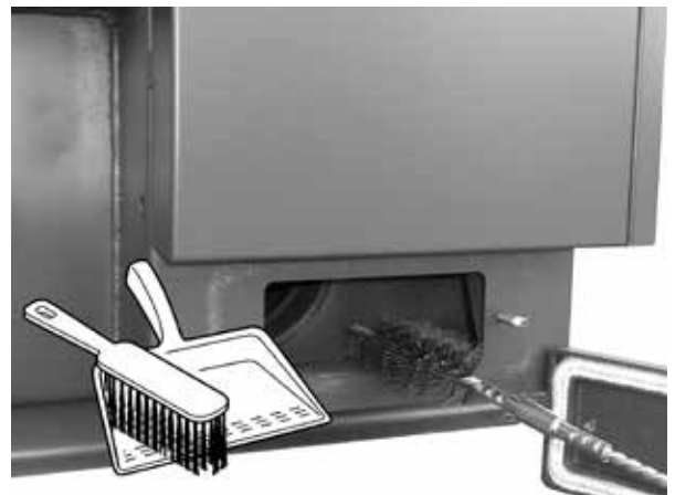
Ukázka čištění kouřového kanálu - spodní víčko
