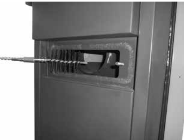
Ukázka čištění prostřední části kouřového kanálu - prostřední víčko
