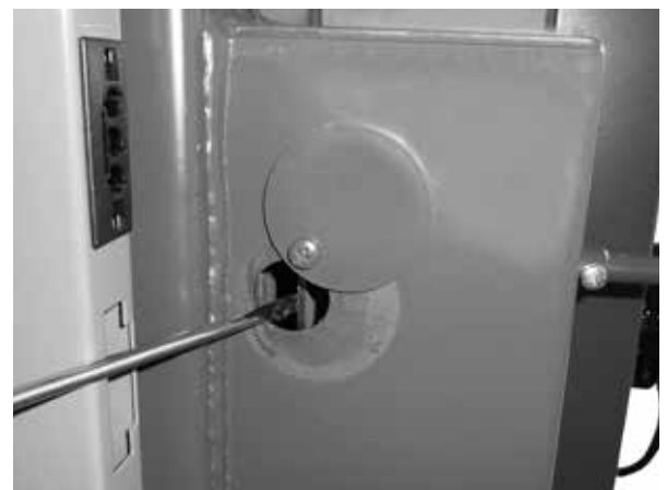
Kontrola a čištění regulace poměru primárního a sekundárního vzduchu čistícím otvorem
