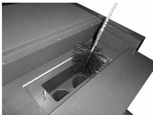
Důkladné vyčištění trubkového výměníku (trubkovnic) kartáčem
