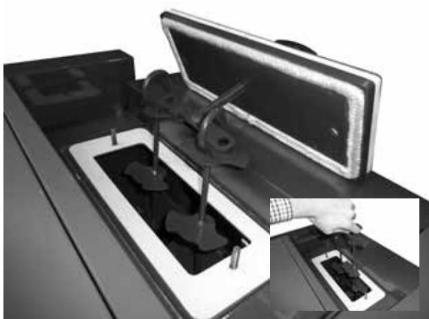
Ukázka vytažení brzdíčů z trubkového výměníku (trubkovnice) před důkladným vyčištěním
