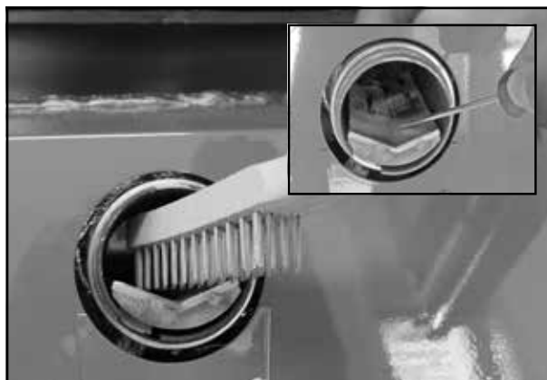
Ukázka čištění prostoru nad deskou žhavicí spirály
