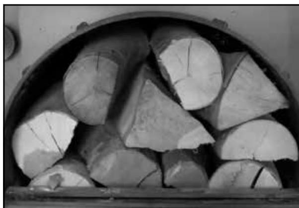
Detail správně naplněné komory
