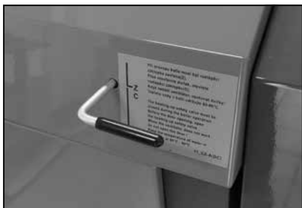
Uzavřená roztápěcí záklopka - zasunutě táhlo
