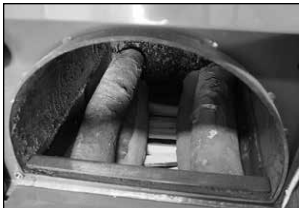
Vložení čtyř větších polen po obou stranách komory (2 + 2 polena)
