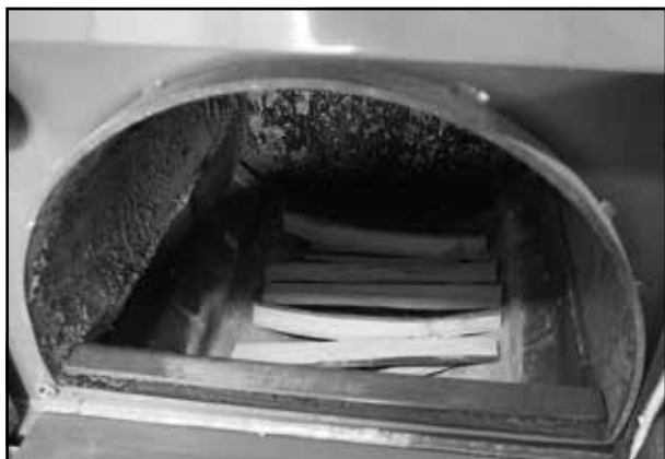
Položení třísek kolmo na otvor zplynovací trysky
