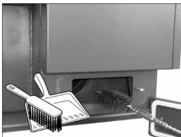
Ukázka čištění kouřového kanálu - spodní víčko
