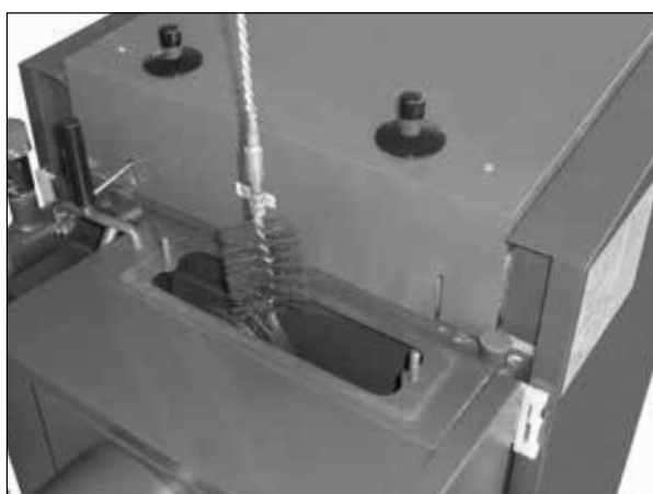
Ukázka čištění kouřového kanálu (trubkovnice) drátěným kartáčem - vrchní víčko
