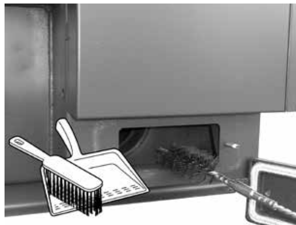
Ukázka čištění kouřového kanálu - spodní víčko
